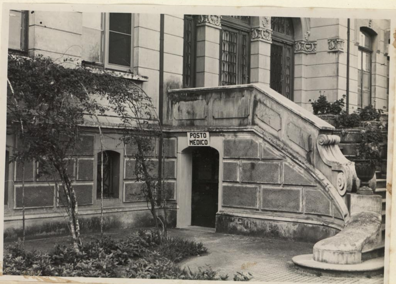
POSTO MÉDICO BUTANTAN (nova instalação)
