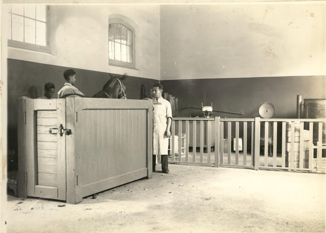
Fotog. 4 - Vista parcial da nova sala de sangria e esterilização.
