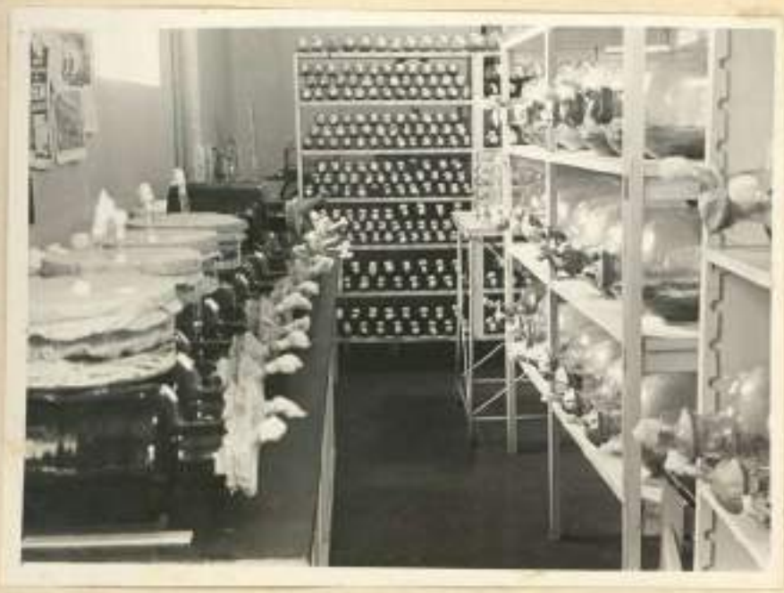
Câmaras de incubação das culturas de Penicillium notatum usadas no Instituto para o ensaio da produção semi-industrial de penicilina.
