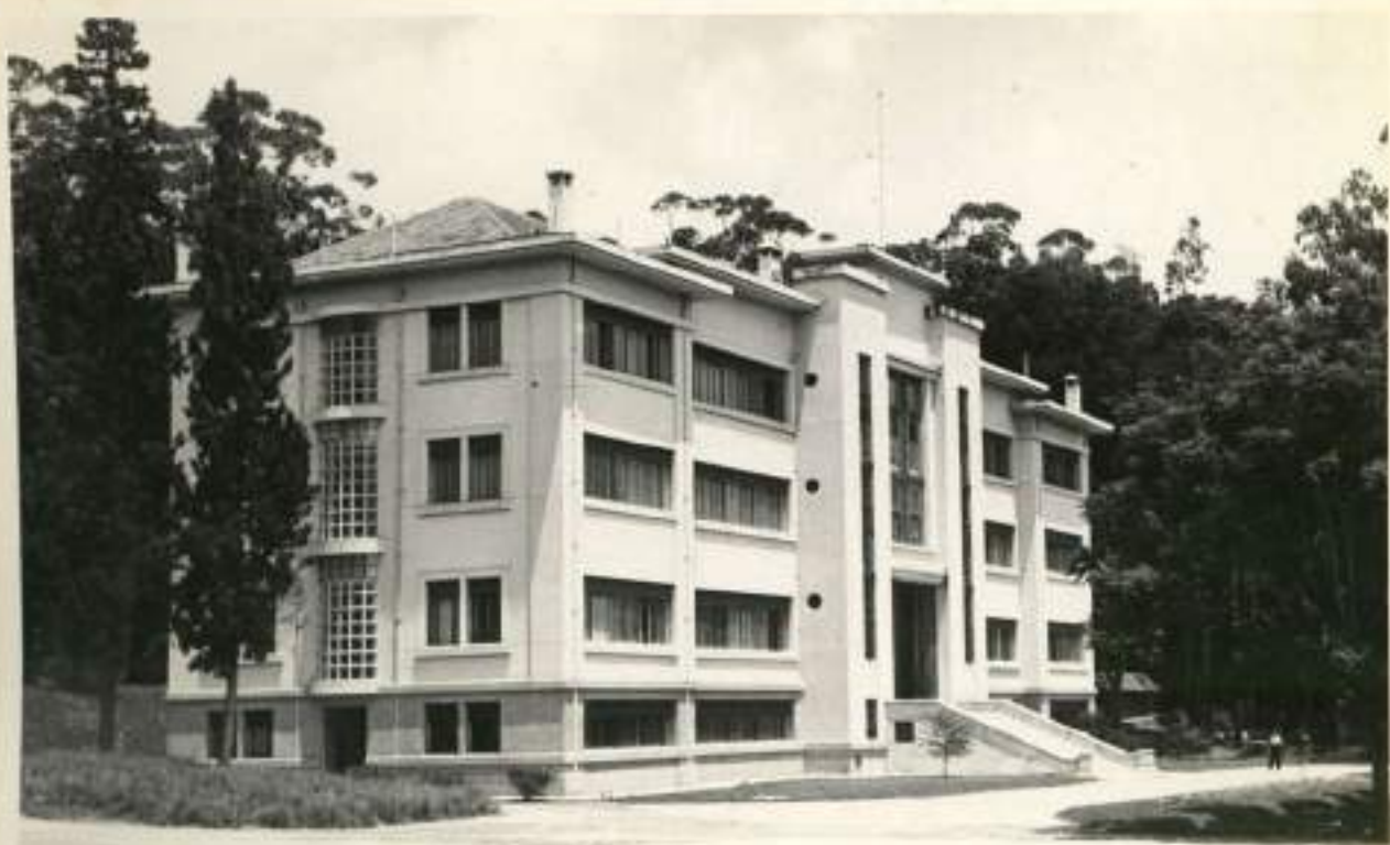
Novo edifício onde se acham presentemente instalados os laboratórios de Bacteriologia e Imunologia
