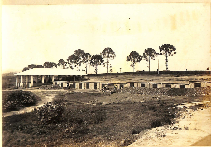
Photo 15) Grupo de cellas de fermentação construído com auxílio da Prefeitura.
